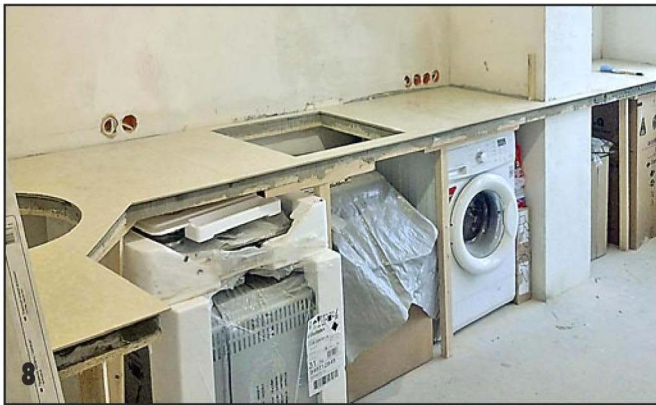
Плитку укладывал без швов. Передние кромки плиток срезаны под углом 45° для плотного соединения с кромочными накладками, тоже выкроенными из плиток.
