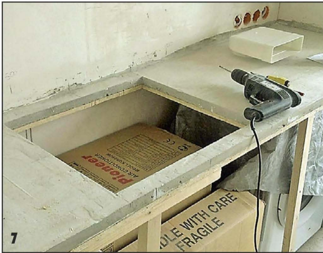
В местах расположения раковины и варочной панели удалил пенопласт и лобзиком вырезал в ОСП соответствующие проёмы.
