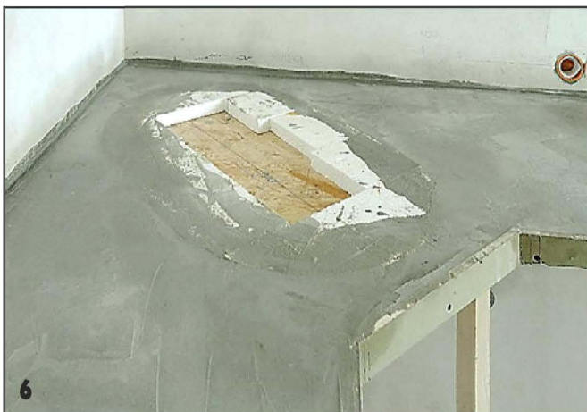
6 Бетонная плита под столешницу отлита.
