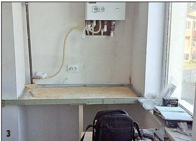
3 Переднюю стенку опалубки сделал из полос гипсокартона.
