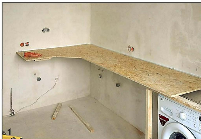
Вырезанное из ОСП основание для отливки столешницы вставил в металлический профиль, закреплённый на стене.
