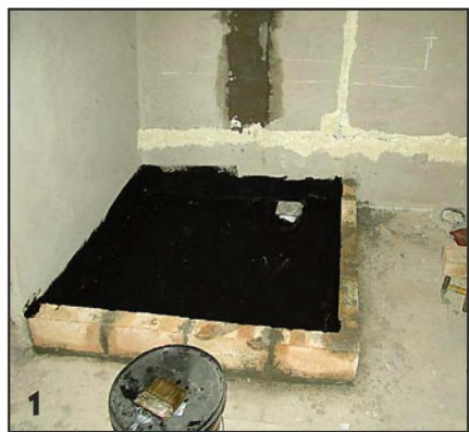
1 Поддон огородил кирпичом на ребро, пол внутри него заизолировал битумной мастикой.
