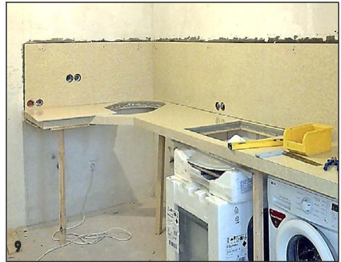
Кромочные плитки приклеены. Фартук набран из той же плитки, что и столешница.
