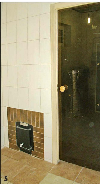
Оформление стены в зоне выхода топки из парилки в душевую.
