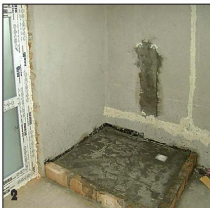
2 По гидроизоляции уложил утеплитель и залил сверху бетоном.
