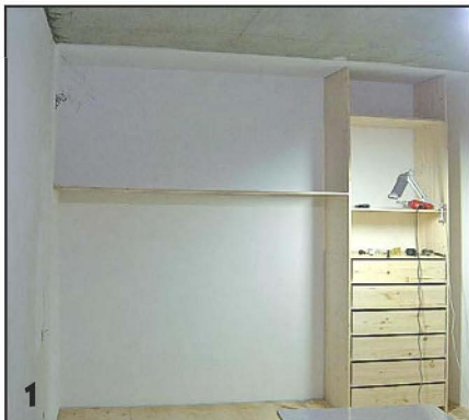
Сначала была изготовлена правая секция шкафа, в которую входит комод, а также установлена большая полка в левой секции.
