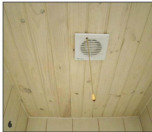
Выключатель принудительной вентиляции совмещено с включением светильника, но если в вентиляторе в данный момент нет надобности, его можно отключить, потянув за шнурок.
