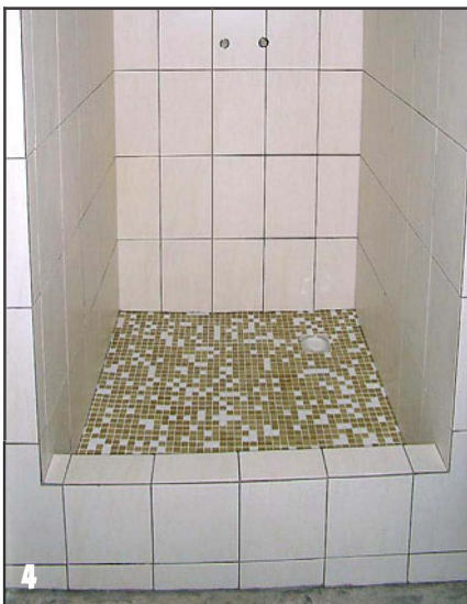
Стены в душевой облицованы светлой плиткой, в поддоне наклеена мозаика.
