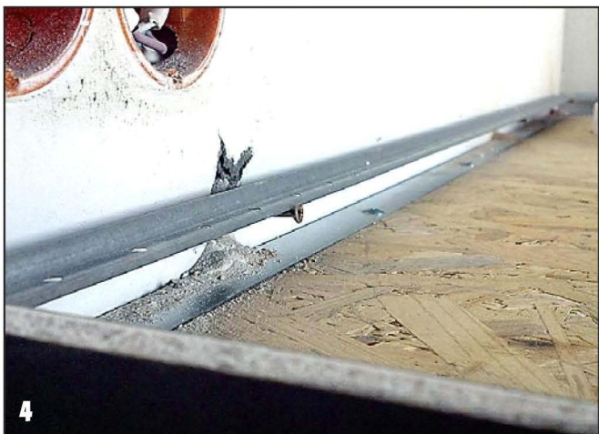
4 На стене закрепил стальной уголковый профиль в качестве направляющего маяка.
