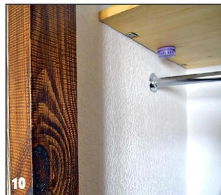
Штанга для плечиков состоит из двух частей, которые крепятся к стойке, стене и перегородке шкафа.
