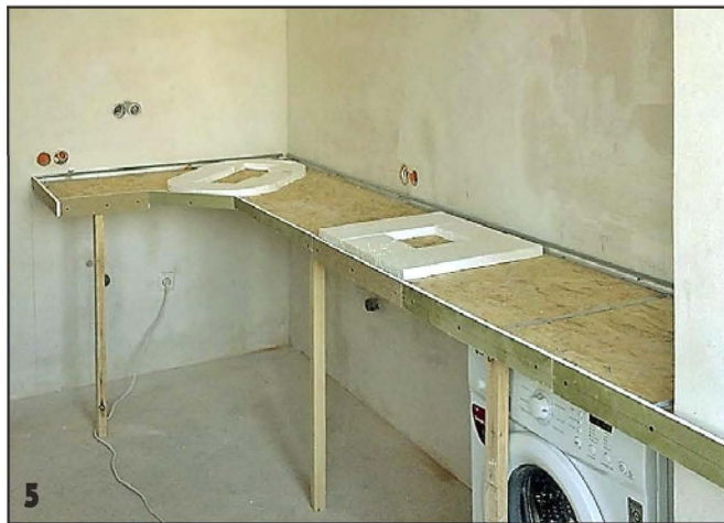
5 Места установки раковины и варочной панели обозначил пенопластовыми вставками.
