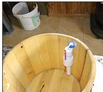
В обливное ведро установил поплавковый клапан.
