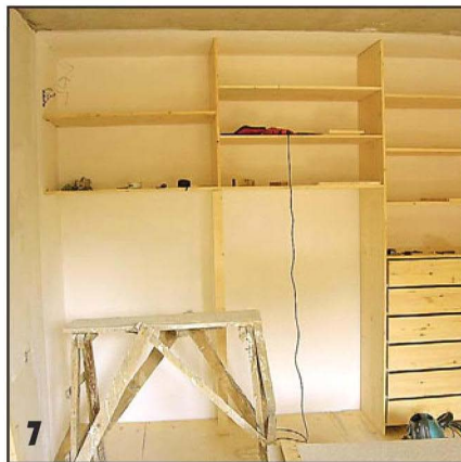
Под большой полкой в левой секции шкафа установлена подпорка из бруса, а верхний объём, в свою очередь, тоже разделён на секции.
