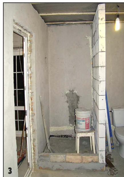
3 Стенку кабины сложил из газобетонных блоков.
