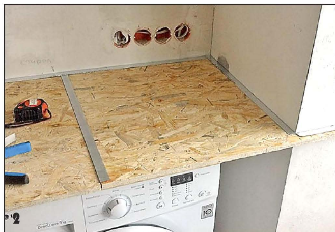
Части основания соединил друг с другом тоже с помощью металлического профиля.
